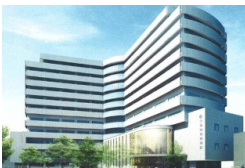
大阪暁明館病院は2013年4月1日に移転し新病院をオープンしました。JR大阪環状線、ゆめさき線 阪神西大阪線 西九条駅から徒歩3分の好立地です。
